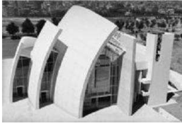
Figure III-10 : Eglise du Jubilé à Rome dans laquelle 600 tonnes de ciment Bianco TX Millenium ont été utilisées pour la construction des voiles courbes de l'édifice.
